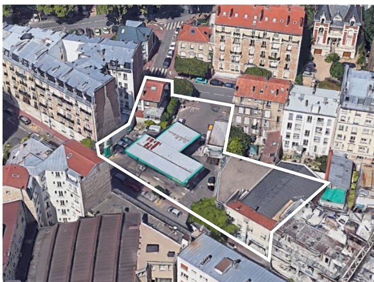
Vue du site
