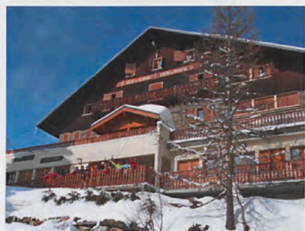
Le chalet municipal à Hauteluce, en Savoie.
